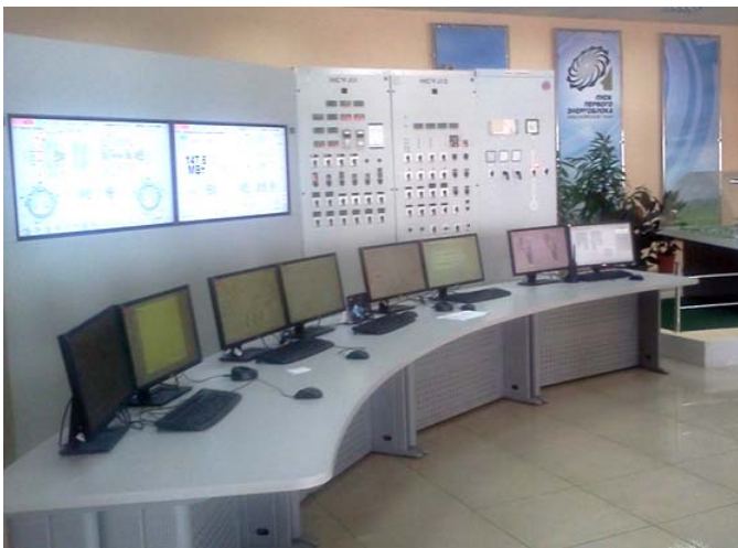
Рис. 1.3. Блочный щит управления на базе ПТК «Торнадо-N» (Красноярская ТЭЦ-3)
